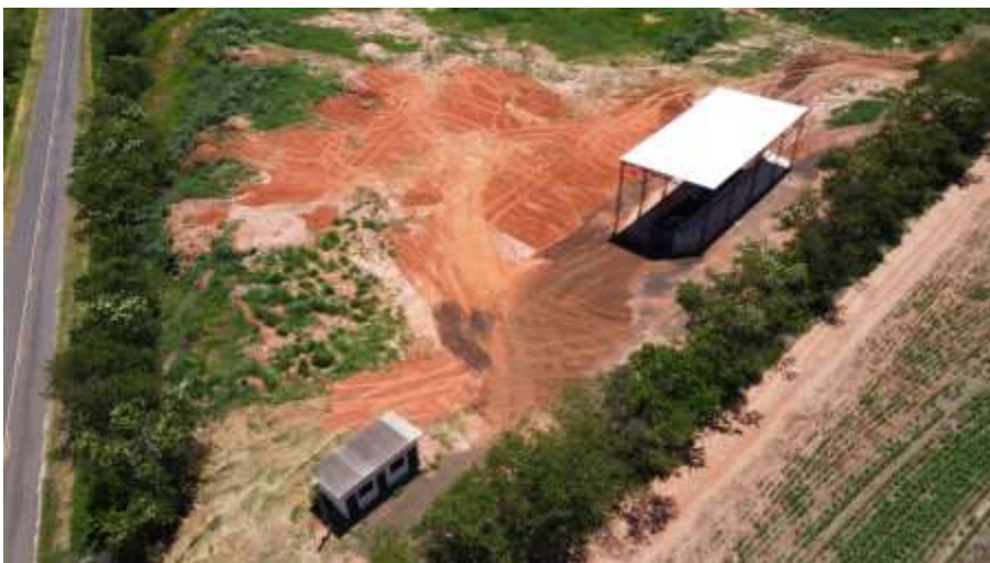
Foto 13 - Cercamento vivo do Aterro
